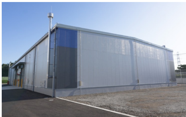
新設した危険物倉庫 つくば市下最大級を誇る
